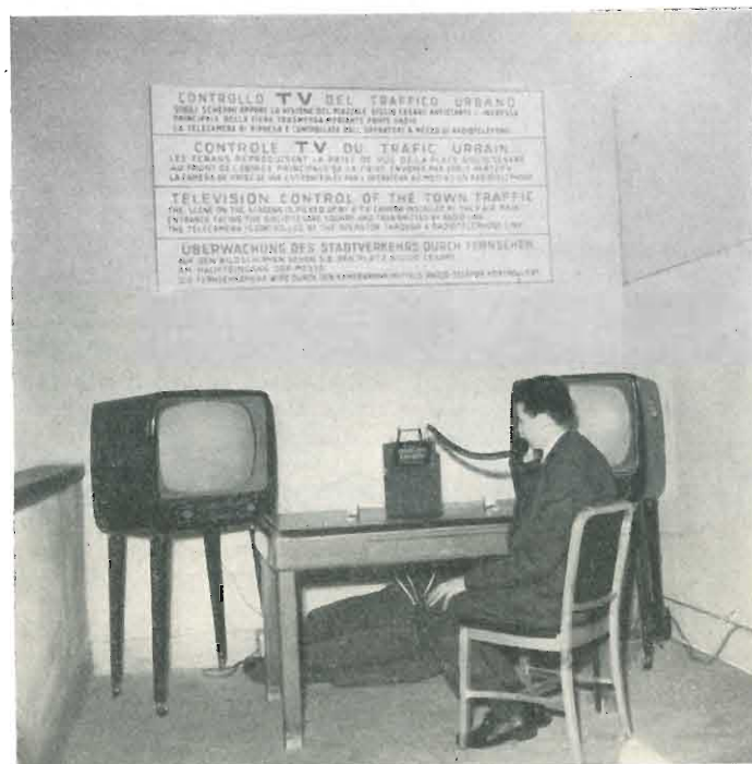
L'osservazione televisiva sistematica e continua di un determinato punto del traffico urbano può essere fatta in un ufficio tranquillo, in contatto radiotelefonico con la telecamera.
