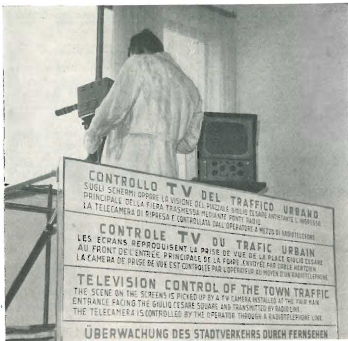
Esperimento di controllo TV del traffico urbano effettuato durante l'ultima Fiera di Milano. La telecamera permette di seguire ogni particolare, essendo facilmente trasportabile.
